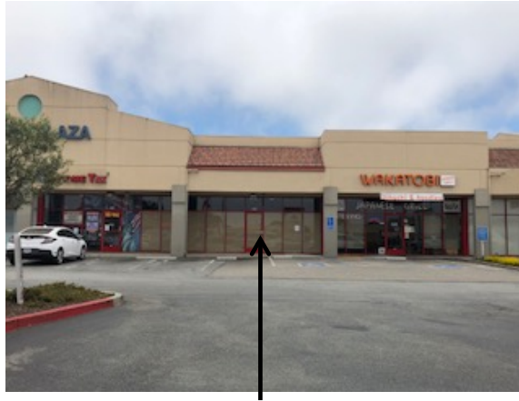
Front façade of tenant space
