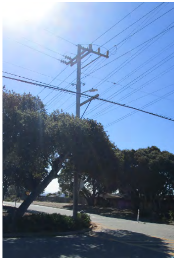
Last pole on Noche Buena St.
